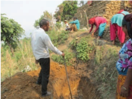
चित्र नं. १२.१.३ कम्पोष्ट मल बनाउनको लागि कच्चा पदार्थ राख्न तयार भएको खाडल
